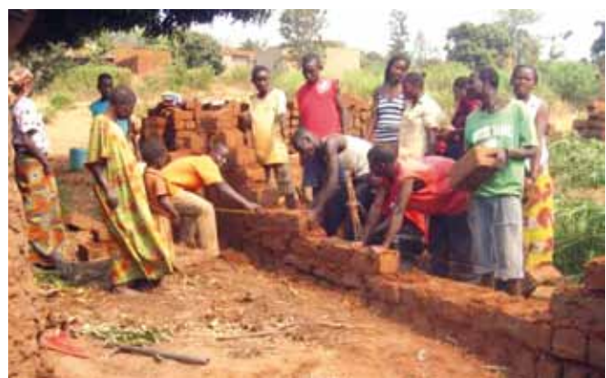
Enfants en vacances à Kamenge et à Kanyosha au cours de la fabrication des briques en faveur des groupes vulnérables
