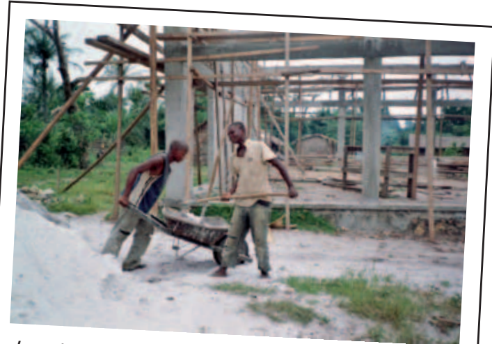
Les travaux ont commencé
