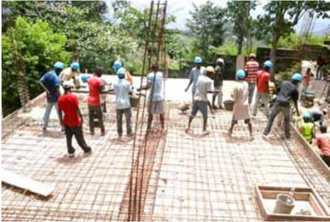
Giessen der Betonbodenplatte des Hühnerstalls
