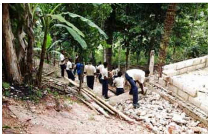
Die Teilnahme der Schüler beim Bau des Hühnerstalls
