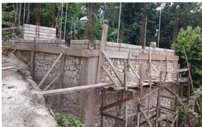
Grande cuve en dessous du poulailler
