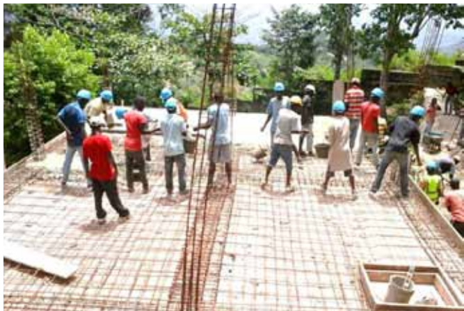
Coulage de la dalle du poulailler
