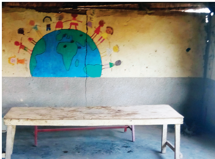
Le hangar d'étude en l'état
